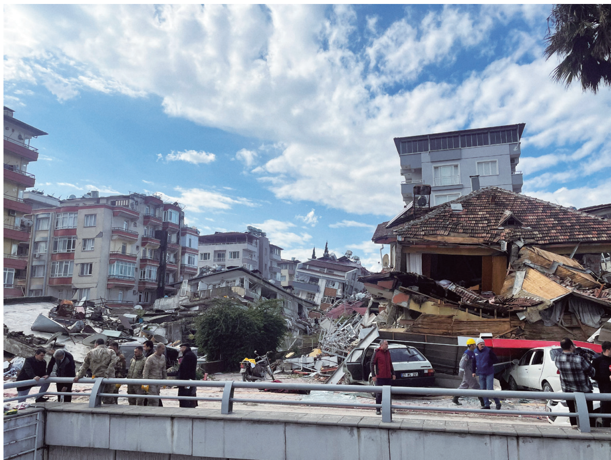
地震で壊れた住宅＝トルコ南部アンタキヤで2023年2月7日、三木幸治撮影
